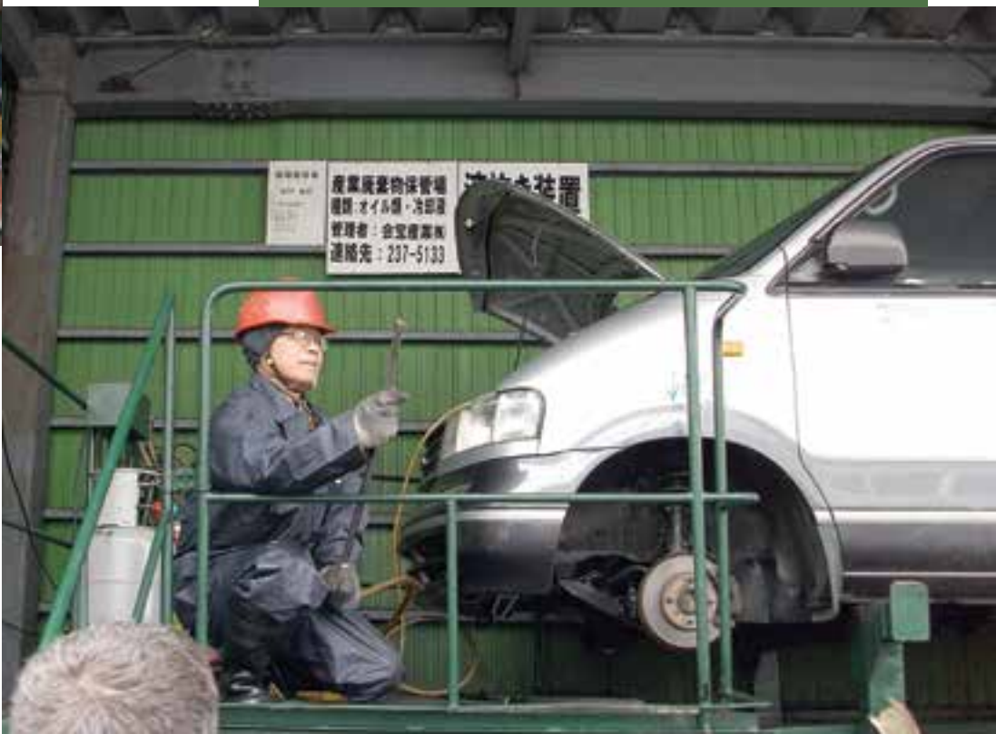
Técnico preparando a remoção dos gases do sistema de ar condicionado – KAIHO SANGYO – Kanazawa - Japão
